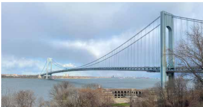
Verrazano Bridge, USA
