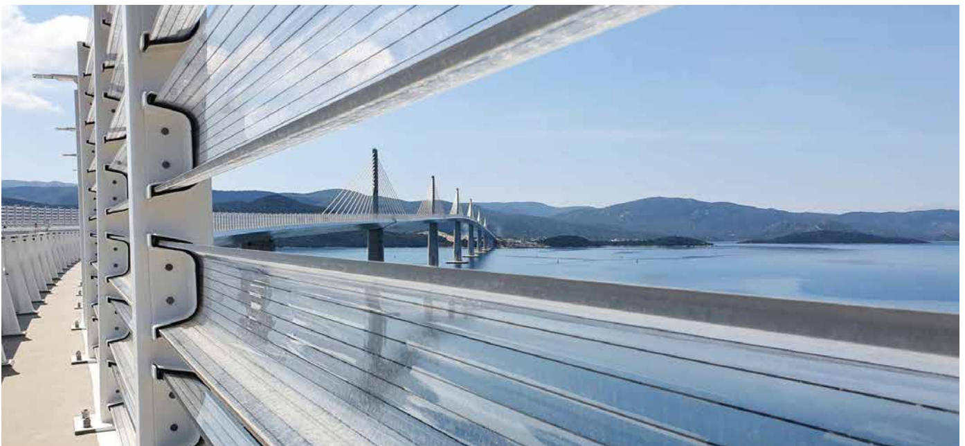
Pelješac Bridge, Croatia*
